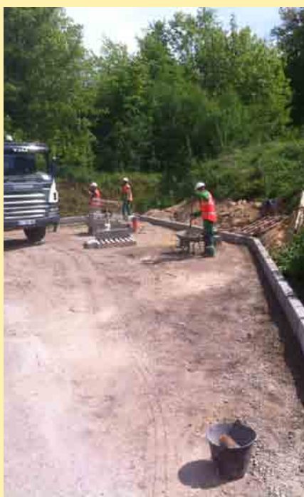
Le Parking de la Chartre en cours de transformation.
